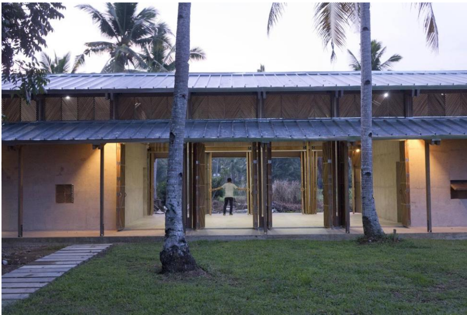
100 | Perspetivas através do edifício.
