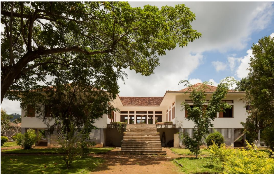
054 | Vista a partir do jardim botânico da casa de passagem
