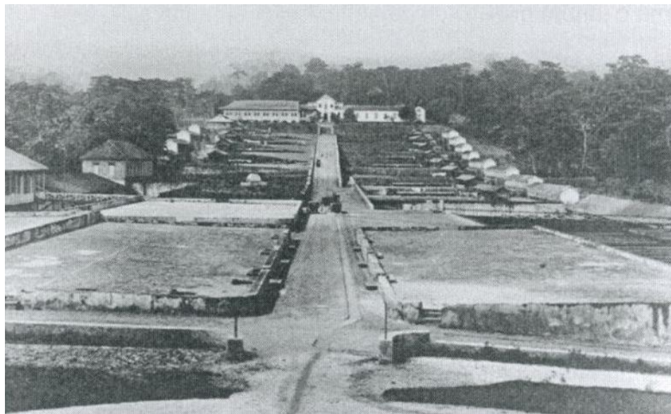
043 | Construção da segunda versão do hospital
