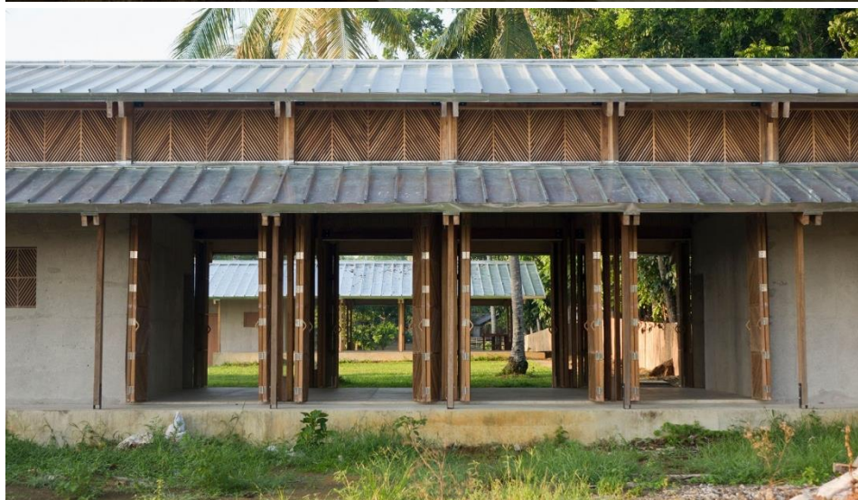
099| Vista através do edifício do centro de estudos.
