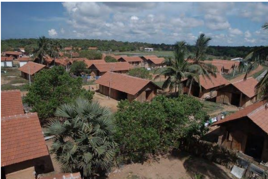
110| Vista superior sobre o conjunto de habitações.
