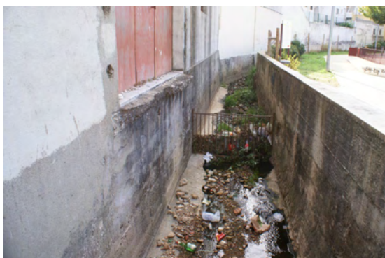
Fig. 76 - Lixo acumulado no espaço público
