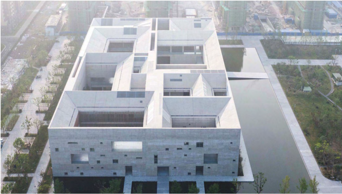
Fig. 140 - Vista aérea do centro de Shou
