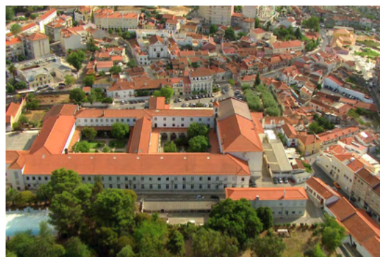
Fig. 103 - Mosteiro de S. Dinis e S. Bernardo, vista aérea
