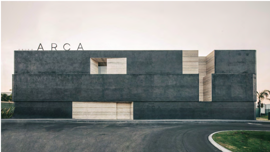
Fig. 188 - Alçado oeste (principal) do Centro de Design do Grupo Arca
