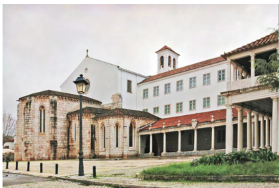
Fig. 102 - Mosteiro de S. Dinis e S. Bernardo, fachada principal
