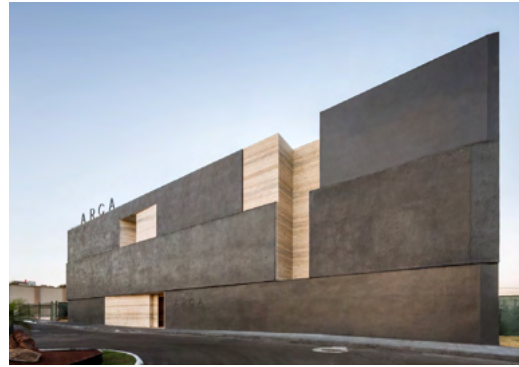
Fig. 190 - Fachada principal vista da Plaza Acueducto, recortes com mármore travertino
