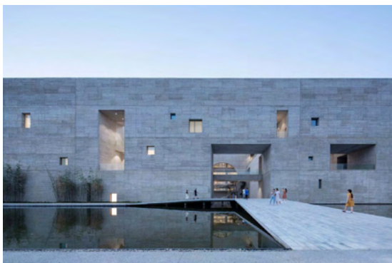
Fig. 147 - Rampas de acesso público pelo edifício
