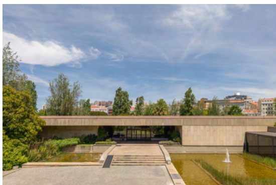
Fig. 171 - Rampas de acesso público pelo edifício
