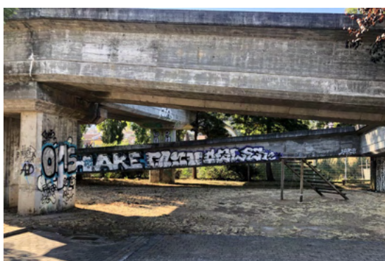
Fig. 120 - Ponte sobre a CRIL
