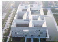
CENTRO DE ARTE E CULTURA DE SHOU - Studio Zhu-Pei • Integração de pátios • Percurso público exterior
