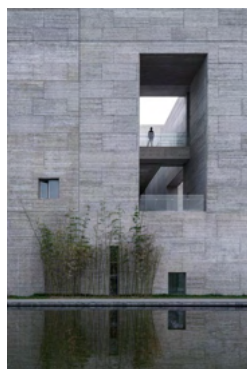
Fig. 145 - Vãos da fachada
