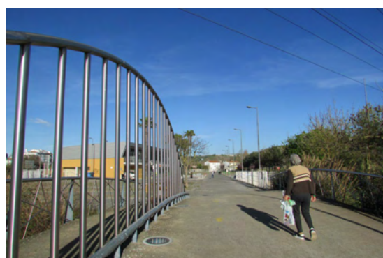
Fig. 121 - Ponte sobre a linha de água
