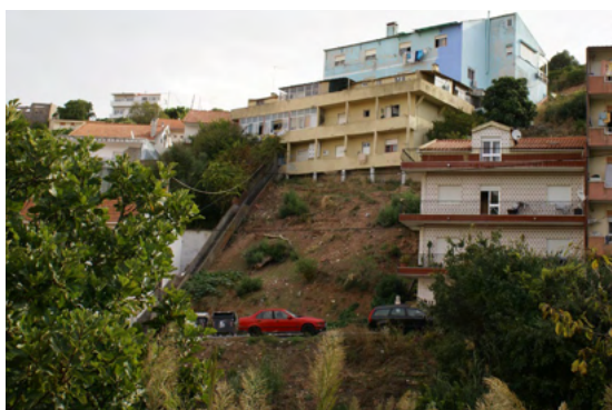
Fig. 74 - Construções na encosta
