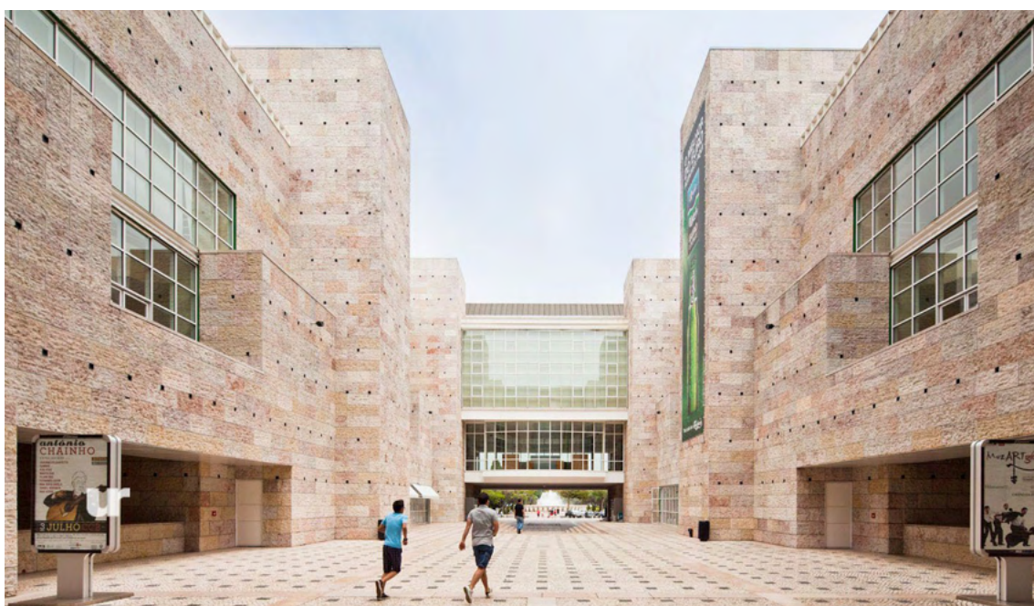
Fig. 155 - Caminho José Saramago no alinhamento da Praça do Império
