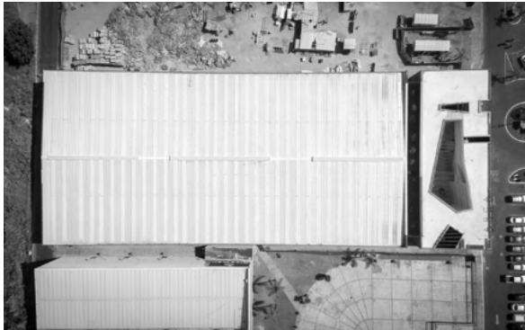
Fig. 189 - Vista de cima do complexo, armazém à esquerda e showroom à direita
