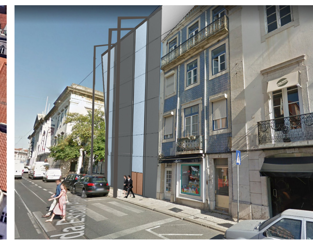
Novo Edifício Habitacional, Rua da Escola Politécnica
