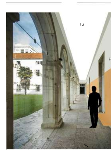
0.42 - PISO 0 - CORREDOR NORTE
