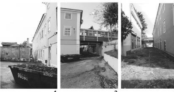
Ex. a reabilitar Passagem a requalificar Zona a requalificar com nova construção
