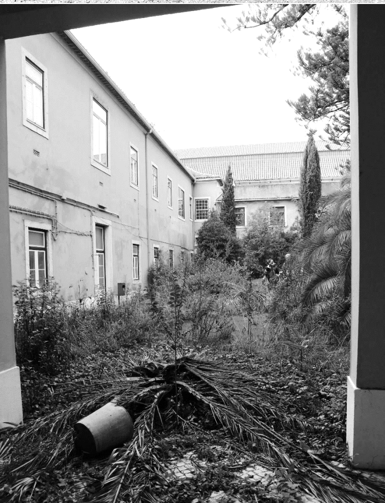
5.1.16 Claustro, Existente, 2019 e)
