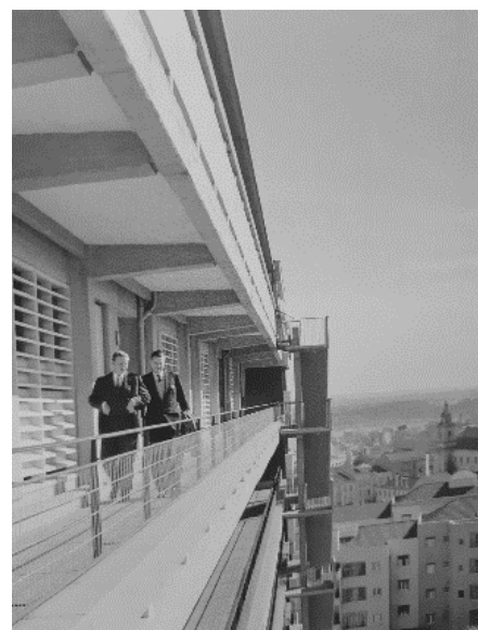
2.5.3 Bloco das Águas Livres, Lisboa Galeria exterior
