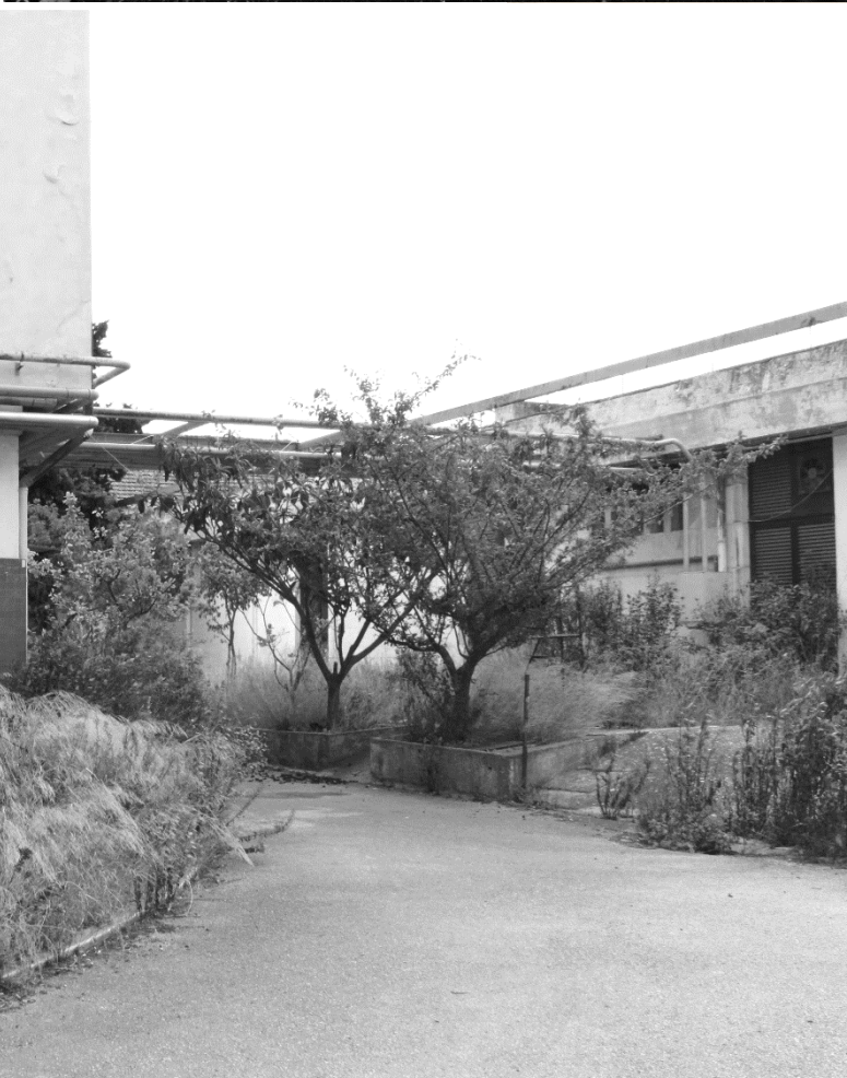
5.1.8 Vista Norte, Existente, 2019 b)
