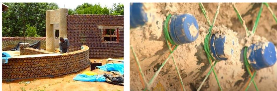
Figura 168. (à esquerda) construção da casa com a técnica de garrafas de plástico (à direita) pormenor da construção. Fonte: Pensar Contemporâneo (2021) <https://www.pensarcontemporaneo.com>.
