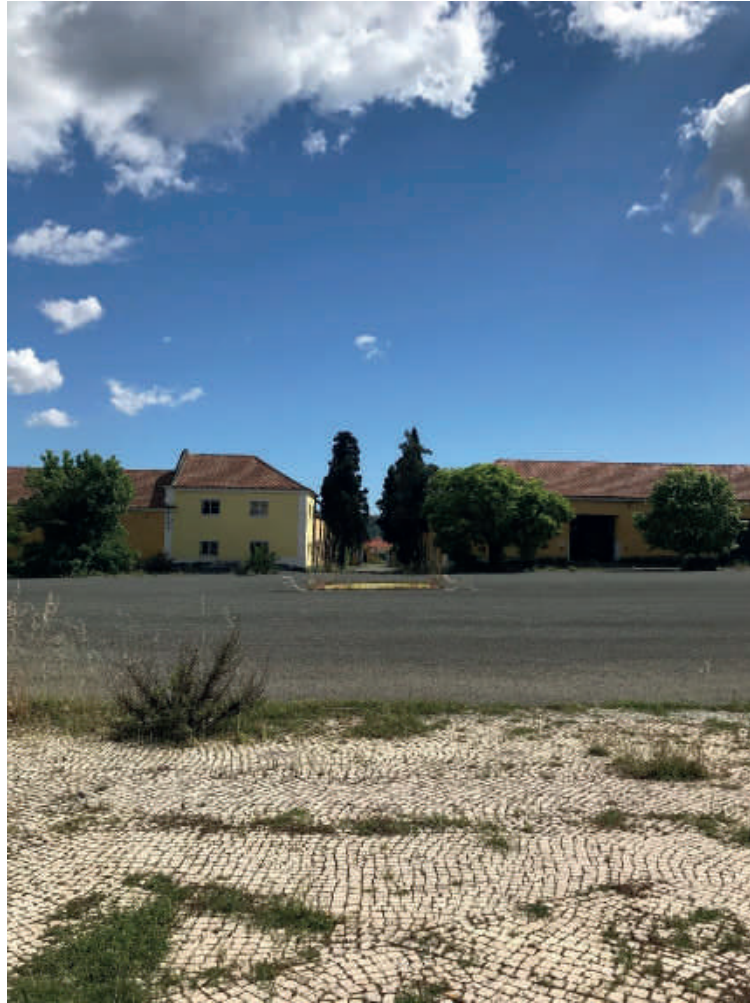
25. Vista para “corredor” entre edifícios
