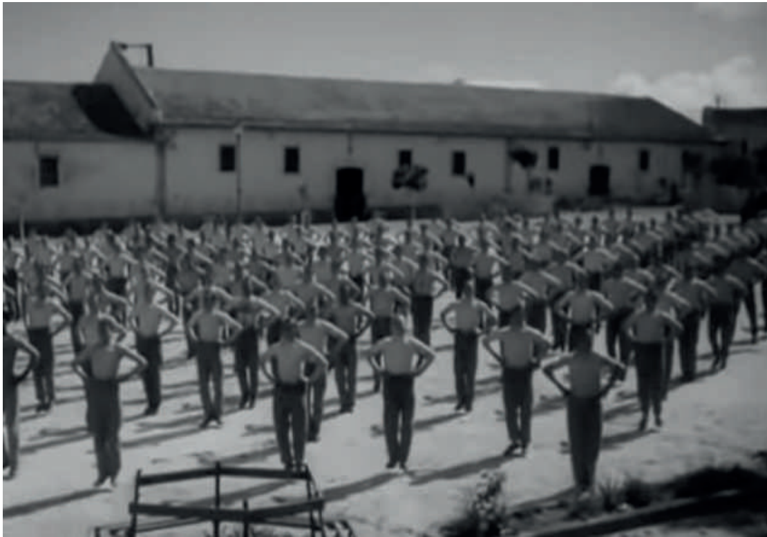
45. FACHADA ORIGINAL DAS CAVALARIÇAS DO QUARTEL
