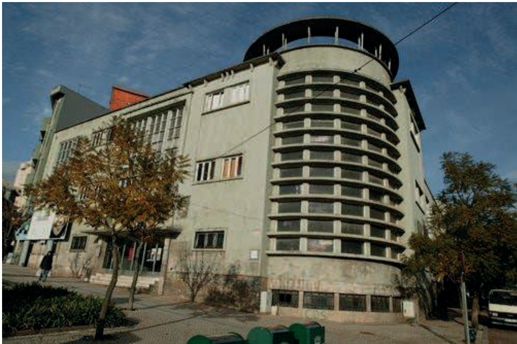
33. EDIFÍCIO ANTES DA REABILITAÇÃO
