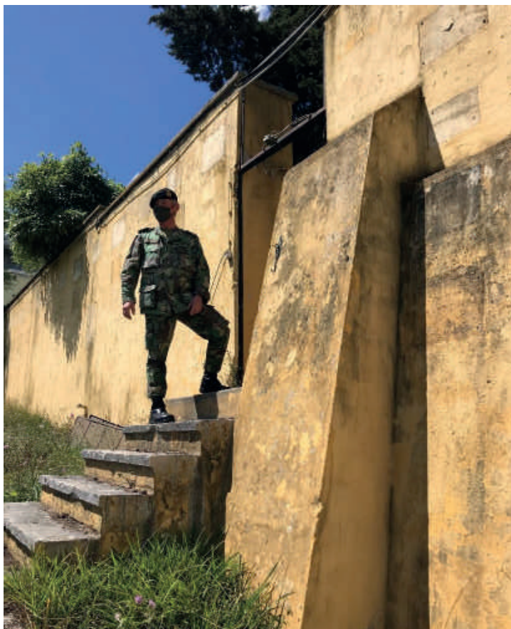
22. Acesso ao “miradouro” do Quartel
