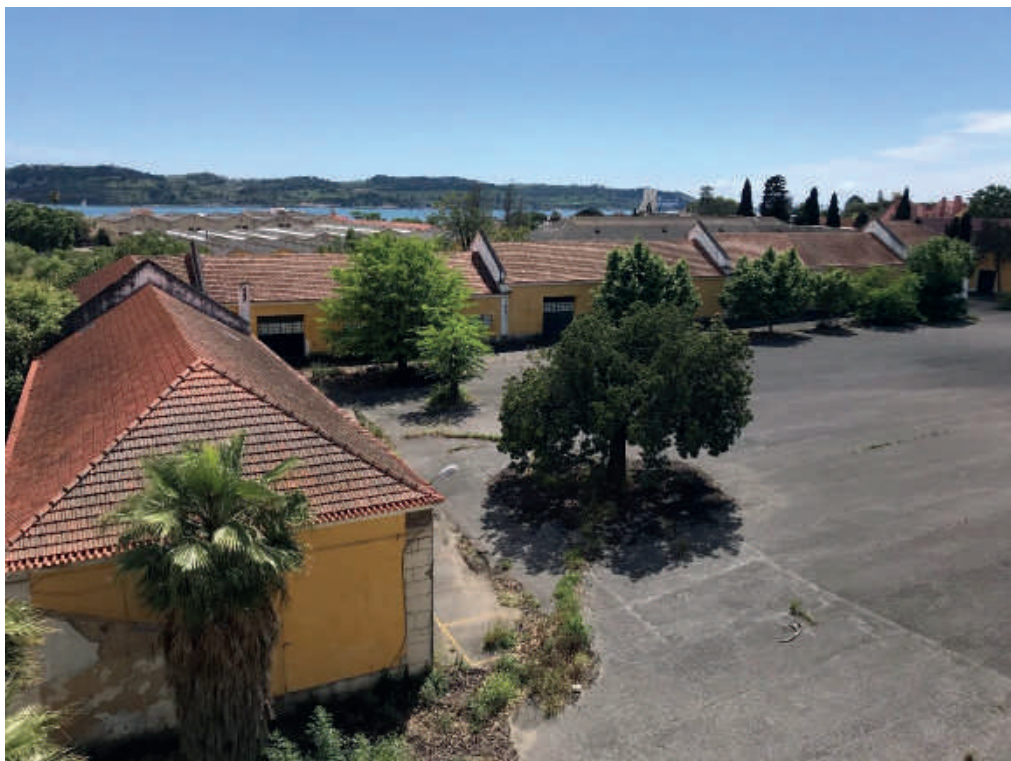
24. Vista do edifício do comando para a parada
