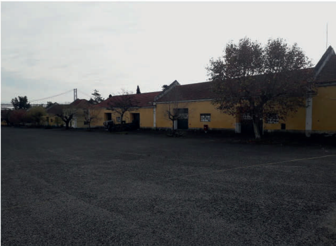
46. FACHADA ATUAL DAS CAVALARIÇAS DO QUARTEL
