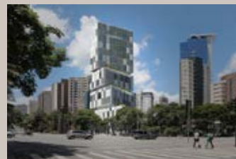
/ EDIFÍCIO CINZEL CINZEL BUILDING Belo Horizonte, Brasil, 2014
